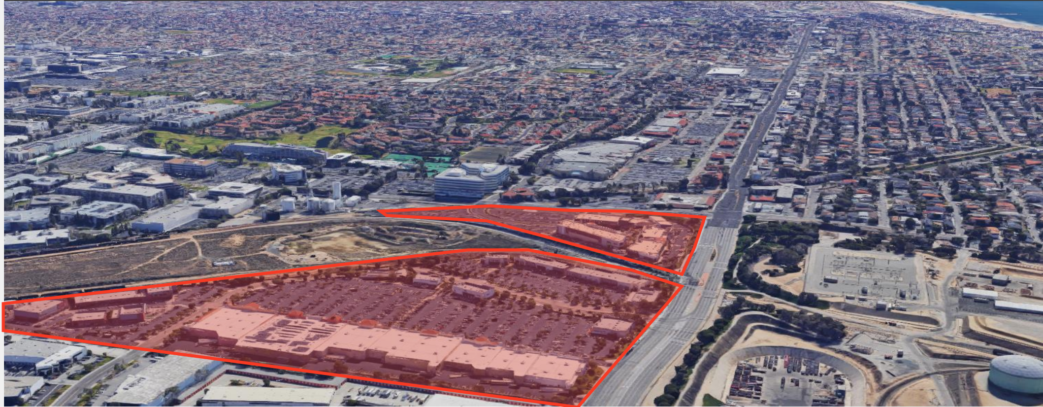
Picture: Plaza El Segundo and The Point, El Segundo, California
